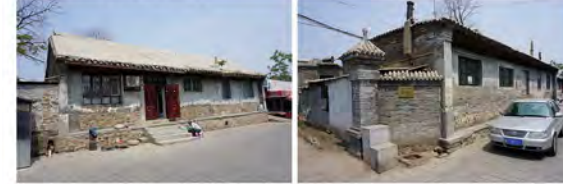
质量较差的建筑
